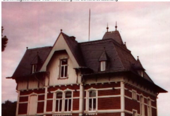
Denkmalgeschützte Villa in Arnberg mit Schiefereindeckung
