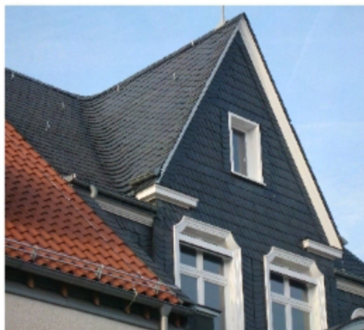
Altdeutsche Deckung aus Fredeburger Schiefer am historischen Verlagshaus "Die Glocke" im westfälischen Oelde
