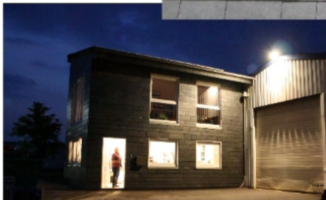
Fassadenverkleidung mit dynamischer Deckung
