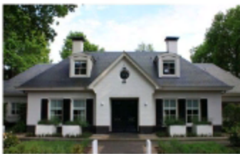
Rechteckdoppeldeckung mit spanischem Schiefer an einer Villa Nähe Eindhoven
