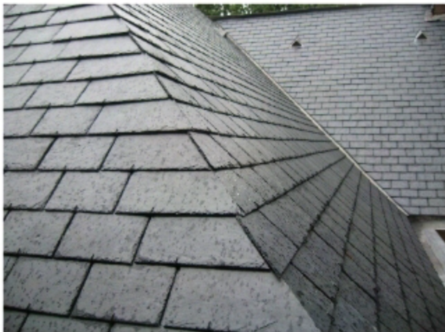
Dach mit "Maasdekkung" (Rechteckdoppeldeckung) und Gratausbildung als "transe vlechthoek"
